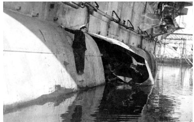
Lo squarcio nella controcarena provocato dall'esplosione
