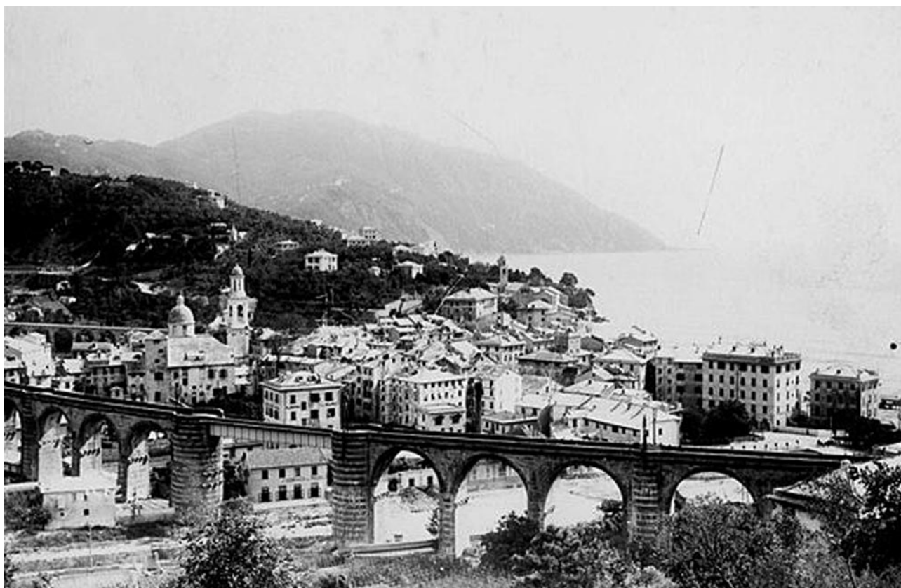
Veduta di Recco con il ponte ferroviario integro
