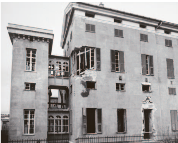
Punto d'entrata del proiettile navale inglese da 381 mm sullo spigolo della facciata del Padiglione VII. Il guasto è minimo rispetto ai danni causati dalla deflagrazione all'interno
