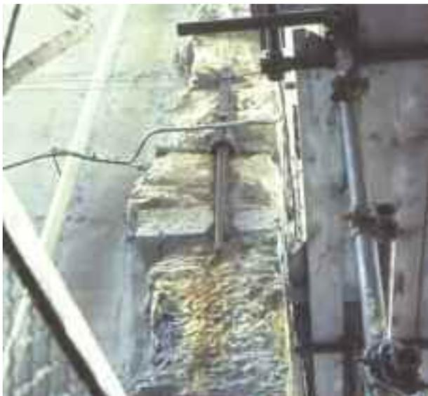
foto 5 - Primo piano del bolzone di una catena messa in opera, durante la costruzione, nella parete portante di un edificio in via di Ravecca.
