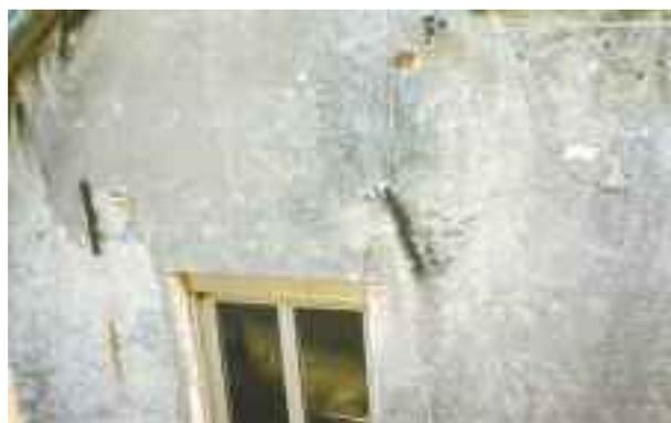
foto 12 - Sulla facciata di un edificio di Salita Coccagna i bolzoni di due *sogofese* segnalano la presenza interna di due travi principali di solaio.
