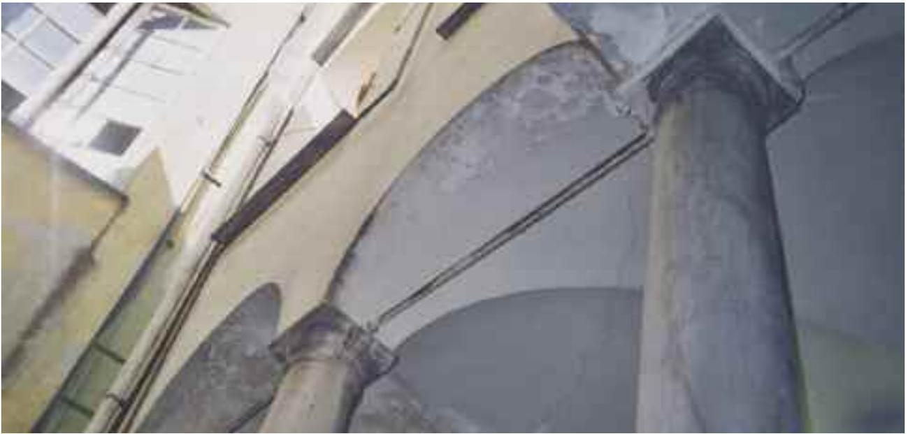
foto 9 - Catene metalliche a servizio della stabilità dei pilastri e delle strutture voltate nel corpo scala di via del Campo n° 2
