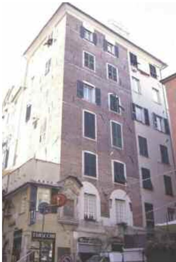
foto 4 - Ben visibili, sulle due facciate di un edificio di Porta Soprana i bolzoni delle catene metalliche affogate nelle pareti durante la costruzione.
