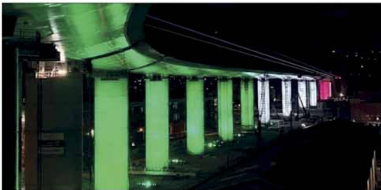
La suggestiva immagine al termine della costruzione dell'impalcato
