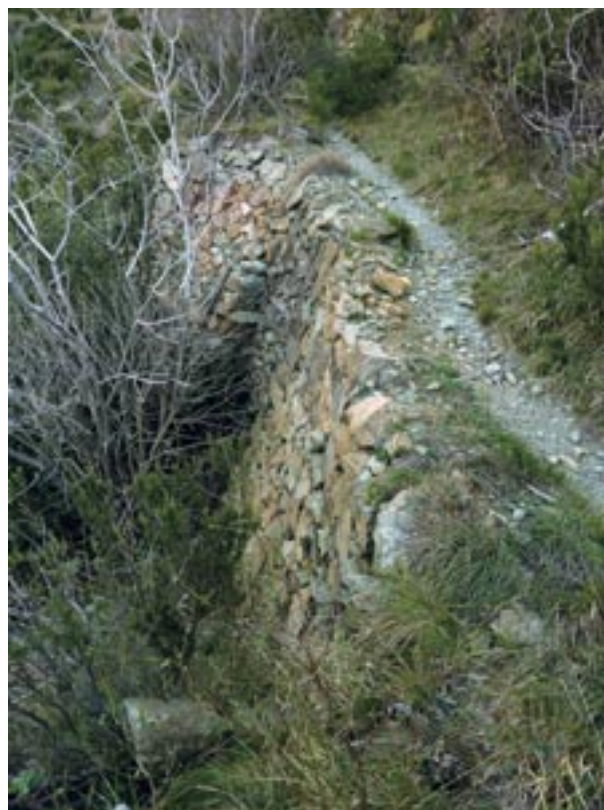
I muraglioni di sostegno dell'ex sede della Decauville
