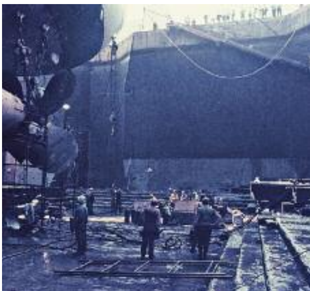
Sistemazione dei ponteggi per il distacco dell'elica
