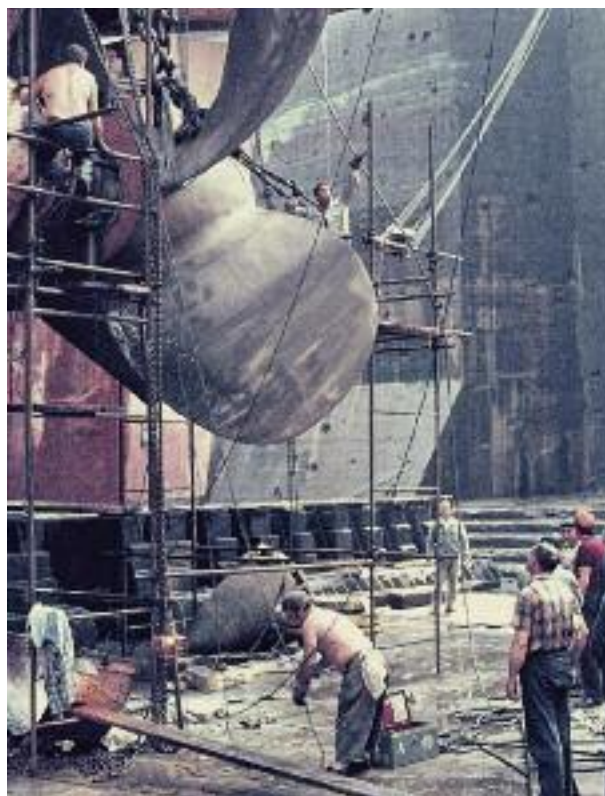
Messa in tensione delle funi per poter sollevare l'elica
