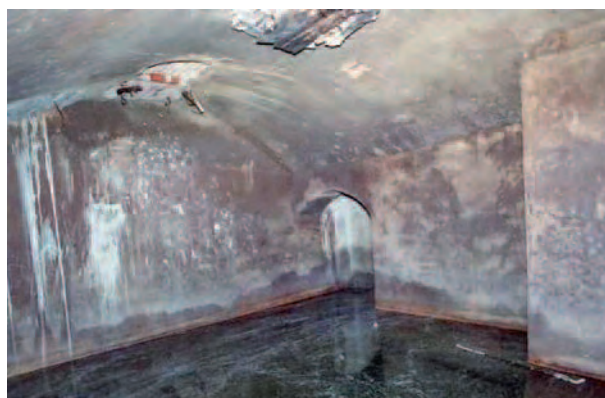
foto 12 - Palazzo Sopranis, la grande cisterna al piano fondi.
