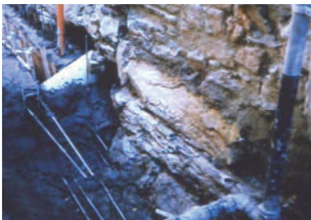
foto 9 - Raro esempio di fondazione a scarpa in un fabbricato di via di Coccagna.
