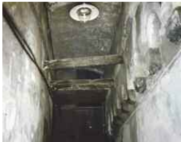
foto 7 - Elementi monolitici posti a contrasto tra due edifici in vico della Pece.
