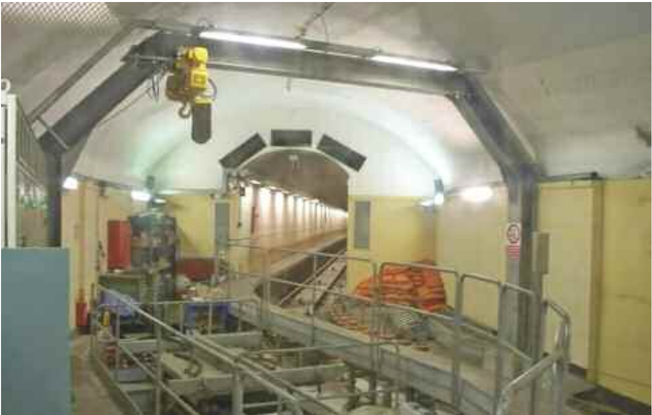
foto 9 – particolare veduta dell’impianto in costruzione
