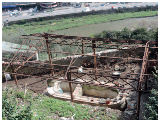
Una fase dei lavori di restauro
