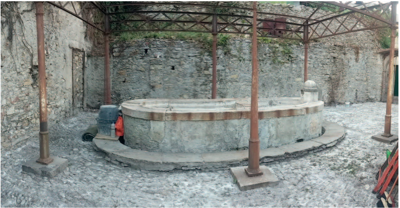
Il lavatoio restaurato
