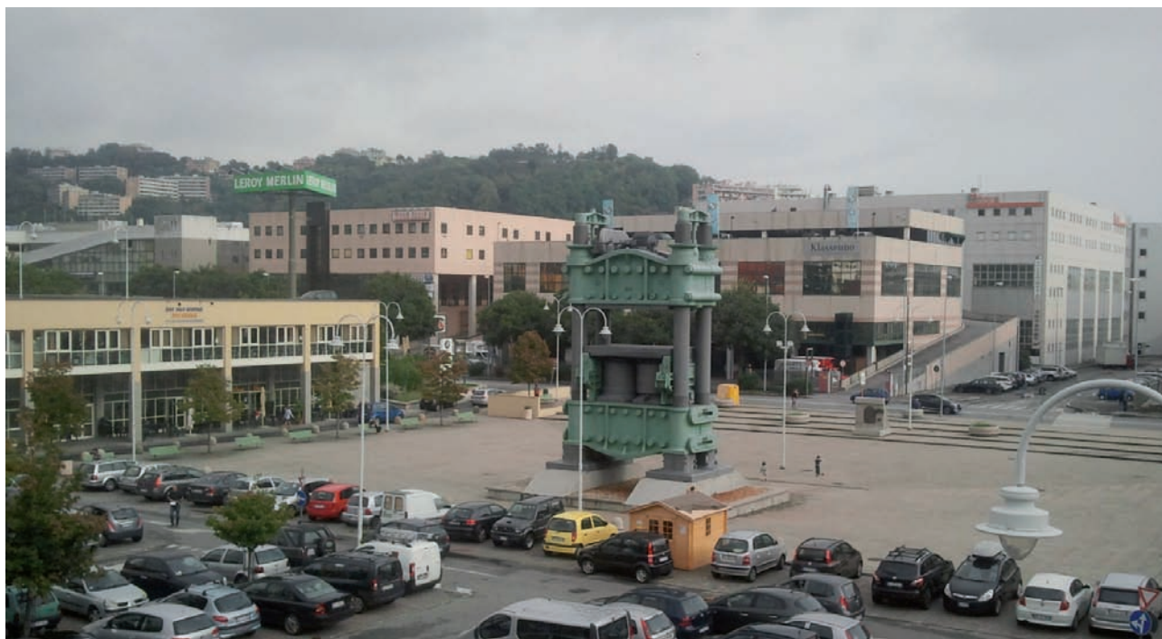
2. Pressa, ex Acciaierie e Fonderie Ansaldo, Genova Campi, 2013 (foto S. Dellacasa)
