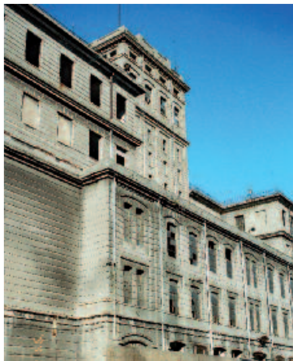
Silos granario Hennebique, Genova - Porto Antico, 2006 (foto S. De Maestri)
