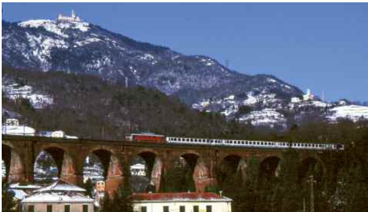
Il viadotto ferroviario Romairone, il Santuario e Livellato, dalla località Biacca di Bolzaneto
