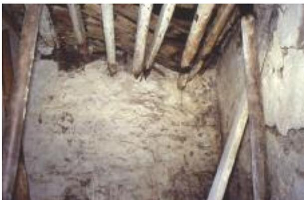
*foto 20* - Lo stesso solaio visto dal sottostante magazzino di piano terra con le travi di sostegno distaccate dal muro per marcescenza delle stesse.
