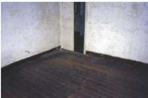
*foto 19* - Pavimento avallato nell'angolo di un locale all'interno n° 1 di via Ravecca n° 14.
