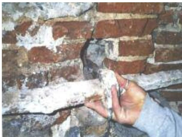
*foto 13* - La foto mostra come l'estremità di una catena si sia talmente erosa per ossidazione da permettere manualmente la rimozione del bolzone.
