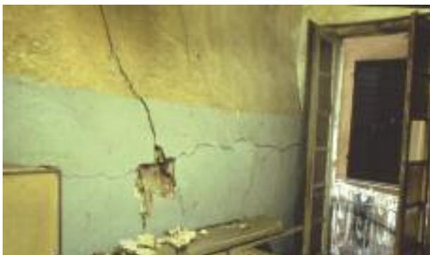
**foto 9** - Magazzino del bar al piano ammezzato dell'edificio di via di Ravecca n° 12. Un tratto della parete portante a comune con il civ. n° 14 e la sua notevole deformata come si presentava ad un primo sopralluogo nel marzo del 1993.
