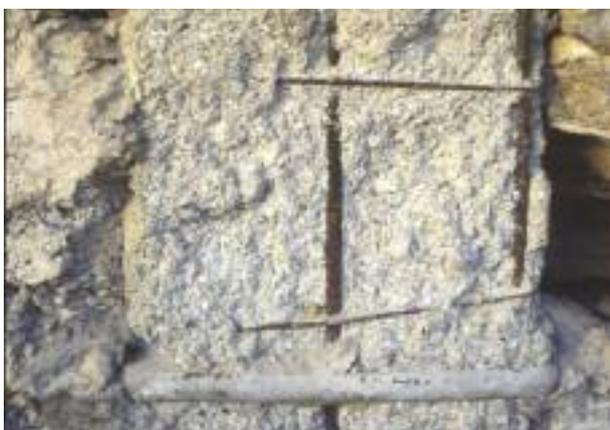
*foto 12* - Lo stato del calcestruzzo in un pilastro di facciata in un palazzo in via Arrivabene a Sestri Ponente.
