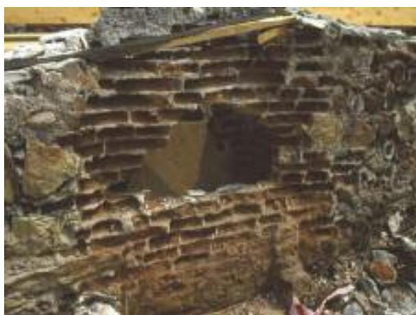
*foto 14* - Il degrado di una parete di mattoni, di qualità scadente, privati della protezione dell'intonaco nel Noviziato di S. Ignazio attuale sede dell'Archivio di Stato.
