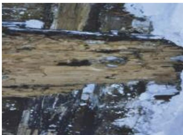
*foto 15* - La trave portante di un solaio profondamente intaccata in profondità da insetti xilofagi.
