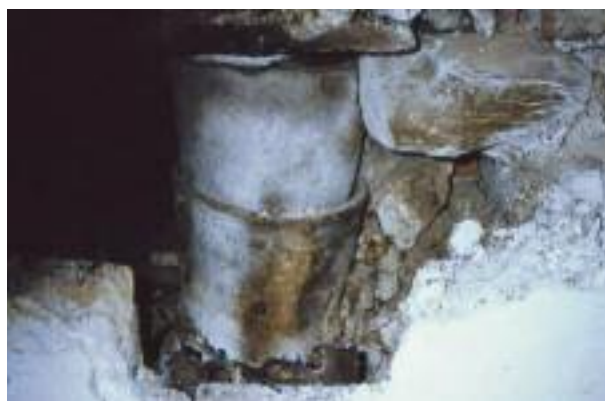
foto 19 - Vecchia condotta in laterizio di notevole diametro inserita in una parete portante di un appartamento in vico del Pozzo.
