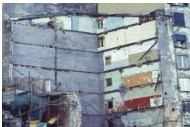
foto 13 - Immagine del crollo, dopo la rimozione delle macerie, del fabbricato in angolo tra vico delle Fate e vico del Fico.
