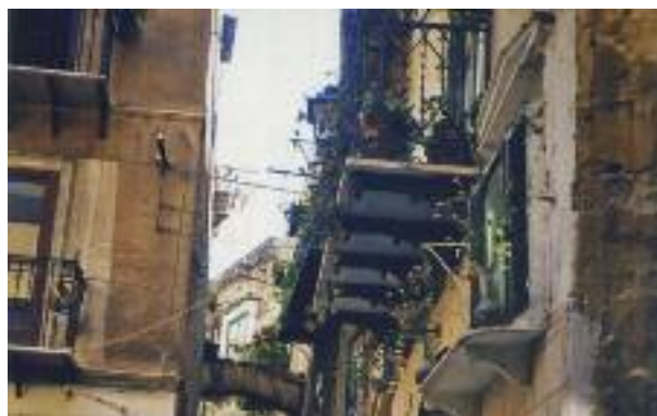
foto 5 - Un balcone molto "prossimo" all'edificio prospiciente nel centro storico di Palermo.
