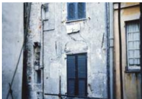
foto 25 - Profonde lesioni negli angoli delle finestre ed effetto arco su quella centrale per il cedimento della piattabanda; civ. n° 34 di via Pre’, facciata su vico Cuneo.
