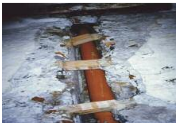
foto 20 - La profonda crena, creata per alloggiare un grosso tubo in plastica, intacca non poco una parete portante all'interno di un appartamento in Prè.
