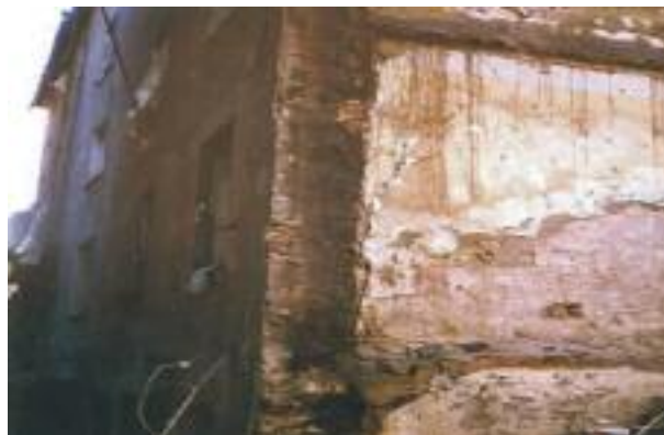
foto 18 - La traccia ben evidente di un vecchio camino all'interno di un muro di facciata dell'edificio crollato nel 1998 in vico Tacconi.
