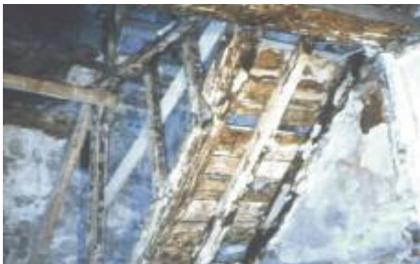
foto 2 - Ossatura lignea di una scala interna in via di Ravecca n° 12.
