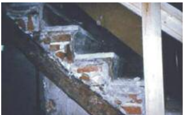
foto 3 - Primo piano di gradini in mattoni pieni, con le piane d'ardesia, sostenuti dai rampanti lignei.
