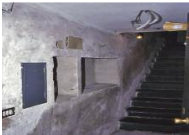
foto 21 - Vani per contatori di utenze varie ricavati nello spessore del muro a piano terra del corpo scala di via di Ravecca n° 10.
