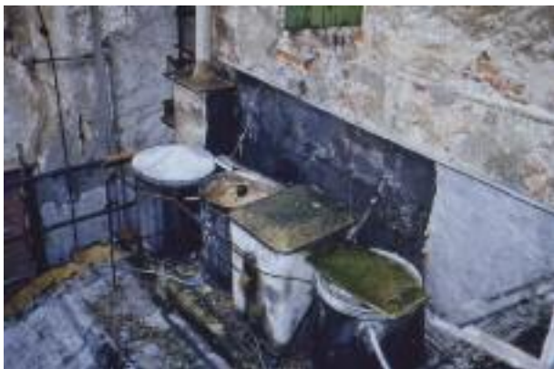
foto 8 - Serbatoi per acqua di varia forma e materiale posti sulla falda di un edificio del "Ghetto".
