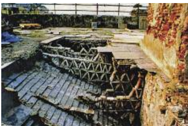
foto 10 - Terrazzo piano di copertura appoggiato tramite mattoni pieni, a "castello di carta", su un tetto in ardesia. Facoltà di Architettura, ex dipartimento DIPARC.
