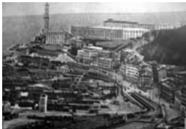
L'area della Lanterna in ristrutturazione
