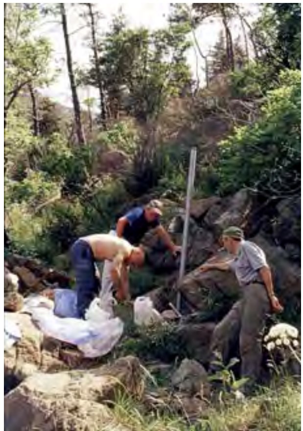
Operatori Sentieri del CAI Bolzaneto cementano il palo della segnaletica verticale ai Fontanin
