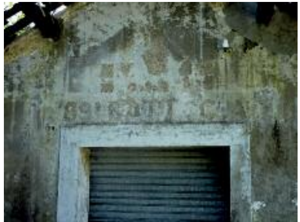
Particolare dell'ex casermetta dell'89ª Batteria della contraerea
