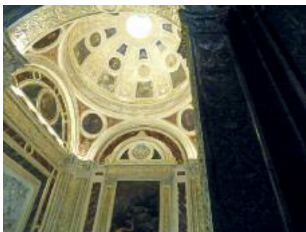
Cappella di San Pietro restaurata
