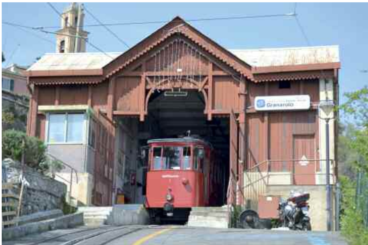
Genova – La stazione della funicolare a Granarolo, costruita nel 1901
