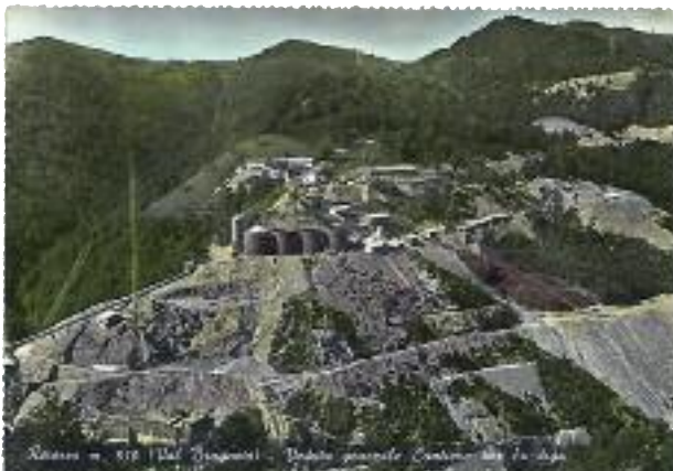
Brugneto veduta cantiere
