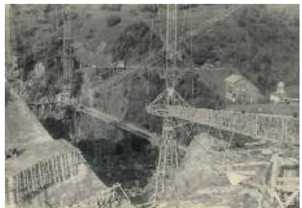
La diga in costruzione
