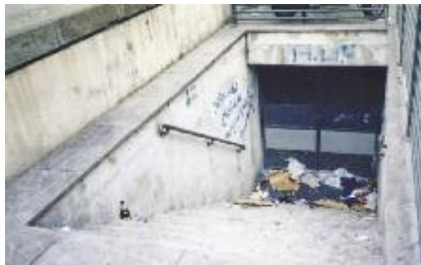
foto 26 - Una delle uscite di emergenza della metropolitana in via Turati a Caricamento.
