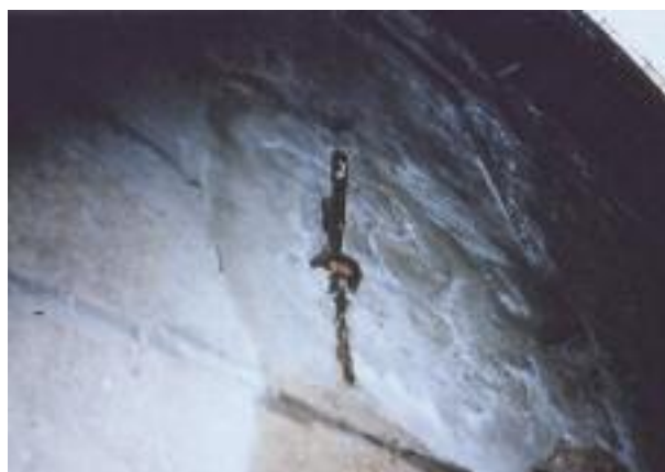
foto 18 - Primo piano del capochiave, o bolzone di una catena, inflesso per eccessivo tiro nella stessa.
