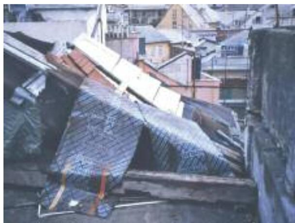
*foto 6* - La protezione posticcia ad un tratto della copertura in un edificio disabitato in Prè che non impediva certo "l'ingresso" delle acque meteoriche nei locali sottostanti - anno 2007.
