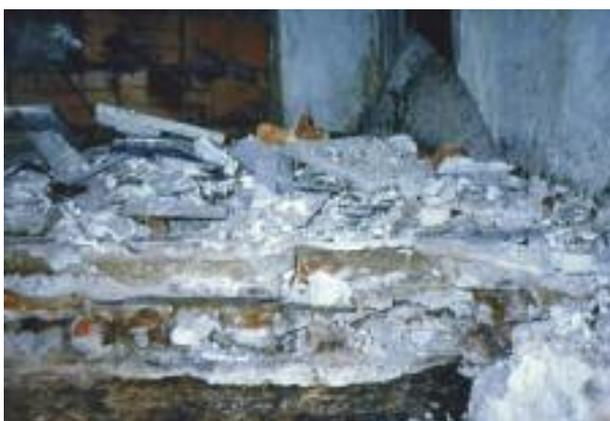
foto 22 - Strati di materiale sovrapposti su un solaio ligneo senza rinforzare la struttura sottostante.
