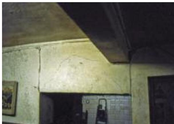
foto 24 - La presenza di una lesione ad arco segnala l’indebolimento della parete non sorretta sul vuoto da un’adeguata piattabanda; via di Ravecca n° 10.
