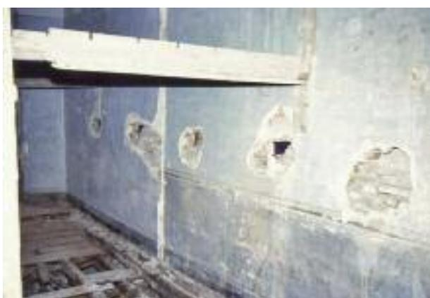
foto 23 - Esempio di come si sia “approfittato” della parete a comune con un vicino di casa, evidentemente “assente”, per appoggiarvi un nuovo solaio in profilati metallici.
