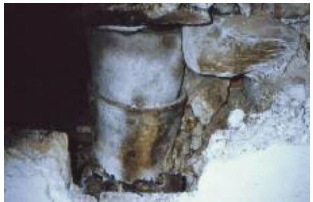
foto 19 - Vecchia condotta in laterizio di notevole diametro inserita in una parete portante di un appartamento in vico del Pozzo.
