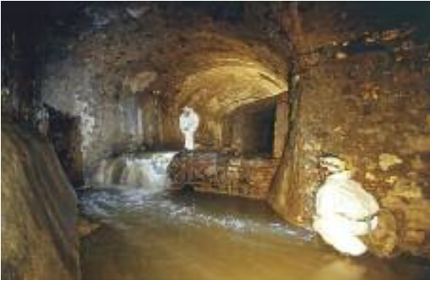
foto 15 - Il tratto della galleria del Rio Carbonara sottostante piazza della Nunziata.
