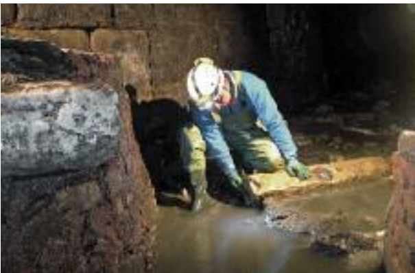
foto 16 - Dettaglio dell'antico acquedotto che, in corrispondenza di piazza Fossatello, attraversa trasversalmente la galleria sotterranea all'interno della quale scorre il Rio Fossatello.
