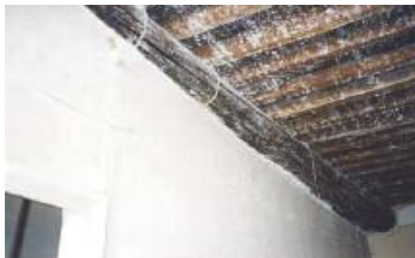
foto 1 - la trave lignea, dormiente, che sulla parete in muratura "accoglie" i travetti di un solaio
