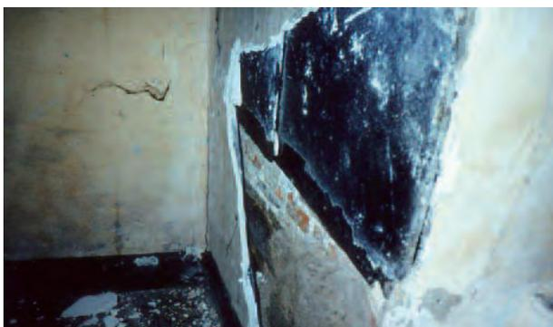
foto 4 - Ben visibili, sulle due facciate di un edificio di Porta Soprana i bolzoni delle catene metalliche affogate nelle pareti durante la costruzione.
