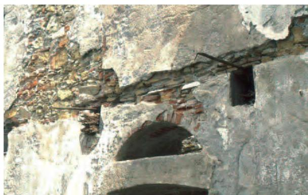
foto 6 - Gli alloggiamenti delle travi principali di un solaio ormai crollato, nell'ex "Refettorio" del Noviziato di *Sant'Ignazio*, che i costruttori del tempo avevano rivestito di lastre di ardesia per proteggerne le teste dall'umidità proveniente dalla parete.
