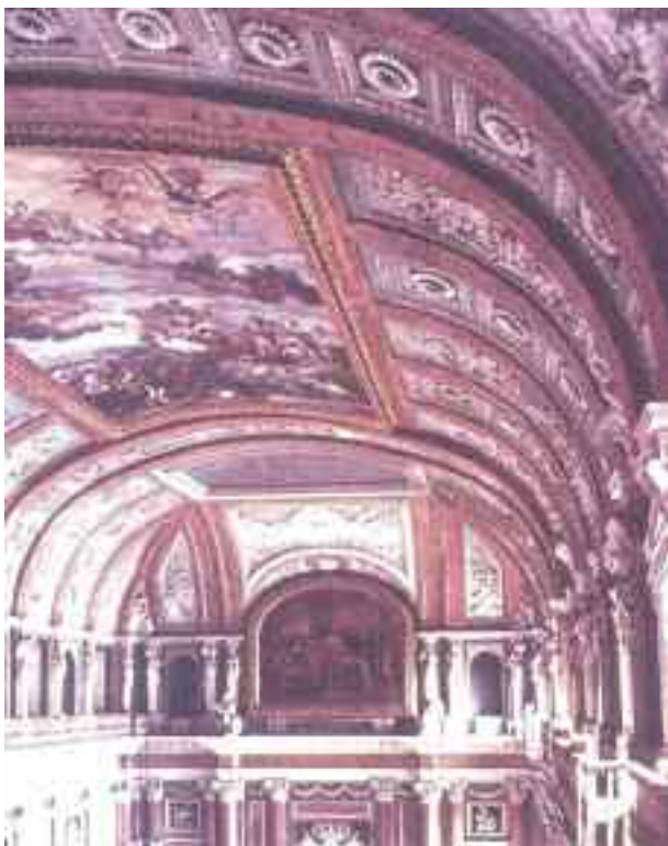
foto 14 – Palazzo Ducale - Salone del Maggior Consiglio. La curva storpiata, in costruzione, di uno degli archi della volta a soffitto.
