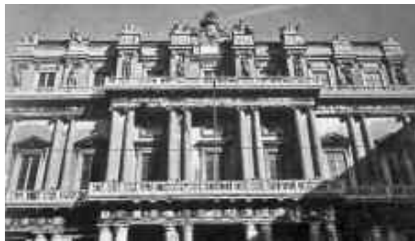
foto 15 – Palazzo Ducale - La facciata su Piazza Matteotti. Al centro le colonne binate in muratura che "contraffortano" la facciata.
