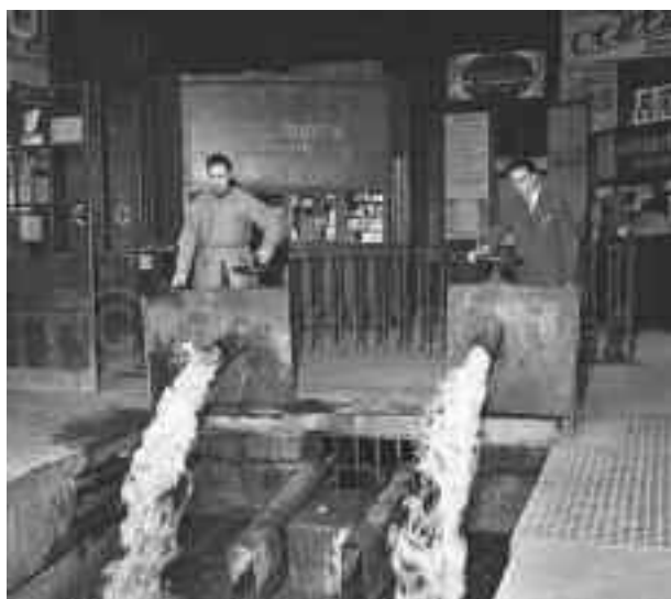
foto 2 – la fase di riempimento dei serbatoi
