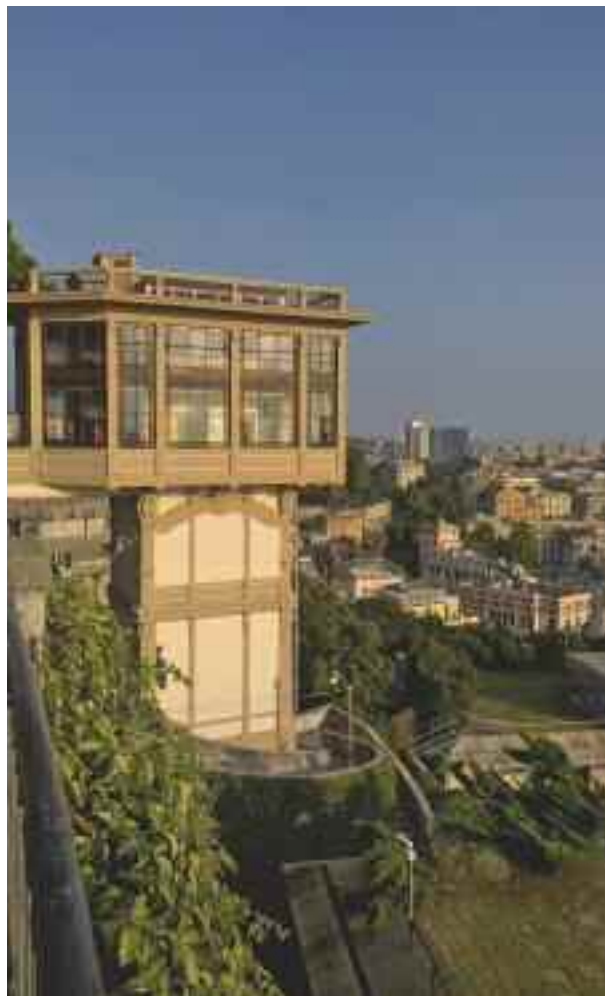
foto 8 – la stazione di arrivo dell'ascensore a Castelletto
