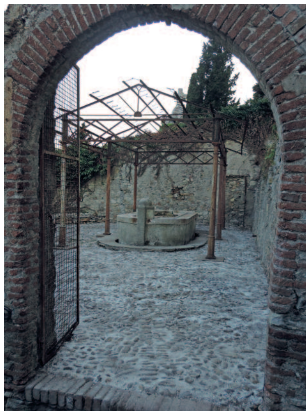
Vista dal cancello d'ingresso prima e dopo i lavori di restauro
