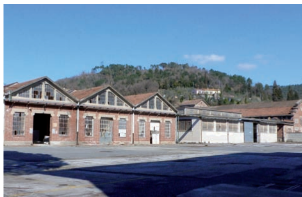
10. Stabilimento ex Ceramica Ligure, Ponzano Magra, La Spezia, 2013 (foto S. Dellacasa)
