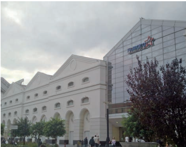
1. Centro commerciale Fiumara, Genova Sampierdarena, 2013 (foto S. Dellacasa)
