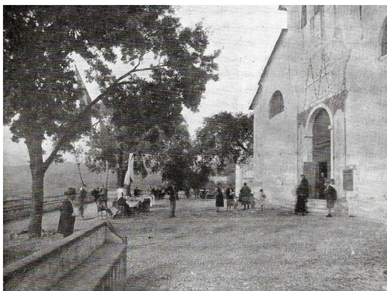
Santuario di N. S. del Monte – Piazzale e facciata della Chiesa ( fot. Sciutto )
