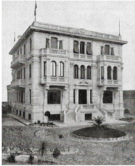
LA GRAZIOSA PALAZZINA DELLO STABILIMENTO VITALE
