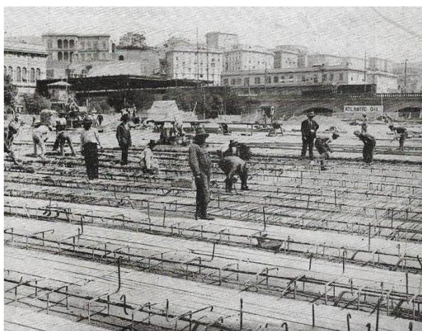
PIAZZAMENTO DEI FERRI PER IL SOLAIO DI CEMENTO ARMATO
