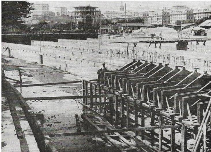
LE PILE CONTINUE E L'ARMATURA PER I SOLETTONI IN CEMENTO ARMATO
