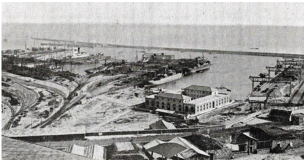
IL BACINO VITTORIO EMANUELE III – L'OFFICINA DI RIPARAZIONE ELEVATORI
